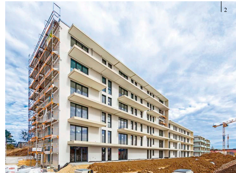
2 | Kurz vor der Fertigstellung: Der erste Bauabschnitt von Hochäcker Mitte kann im Sommer 2017 bezogen werden | Nearing completion: The first section of Hochäcker Mitte will be ready for occupancy in summer 2017
